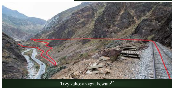
Jedno z wielu miejsc wjazdu pociągu wprost na wiadukt 11
